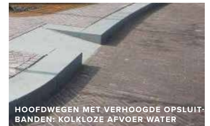
WATERBERGING OPNEMEN IN STRAATPROFIEL
